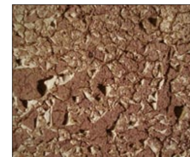
Superficie dopo un incendio
