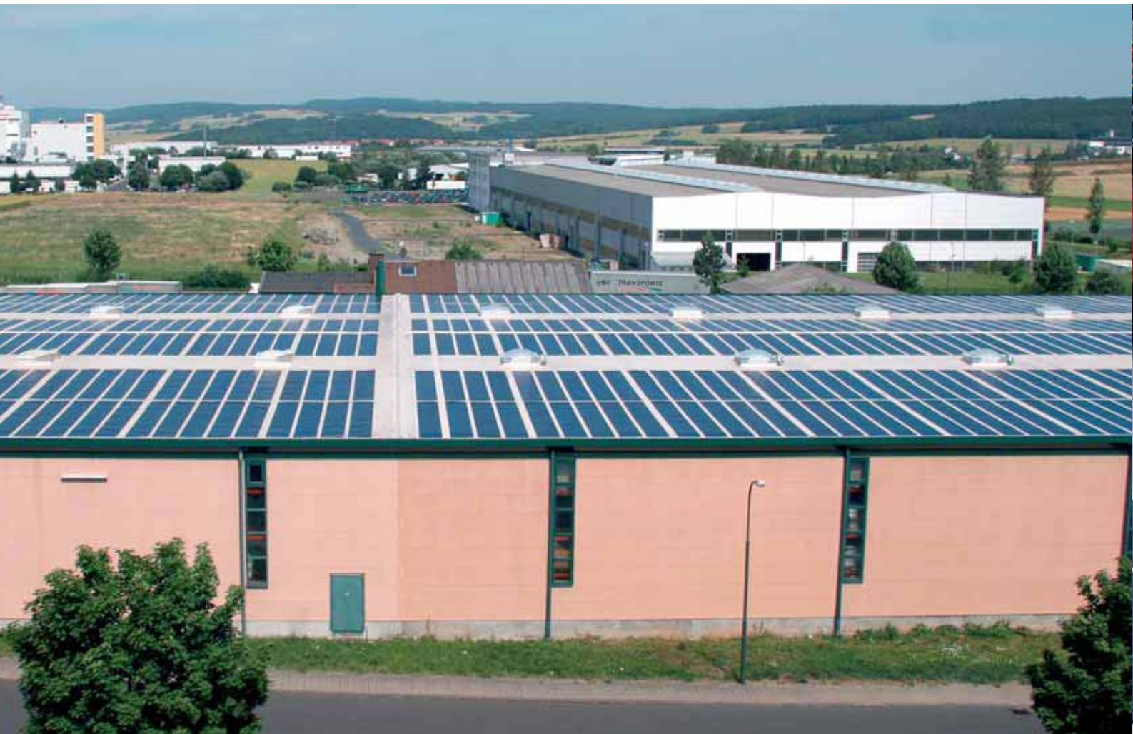
Coperture impermeabile con integrazione celle fotovoltaiche, Fulda, 5000 m 2
