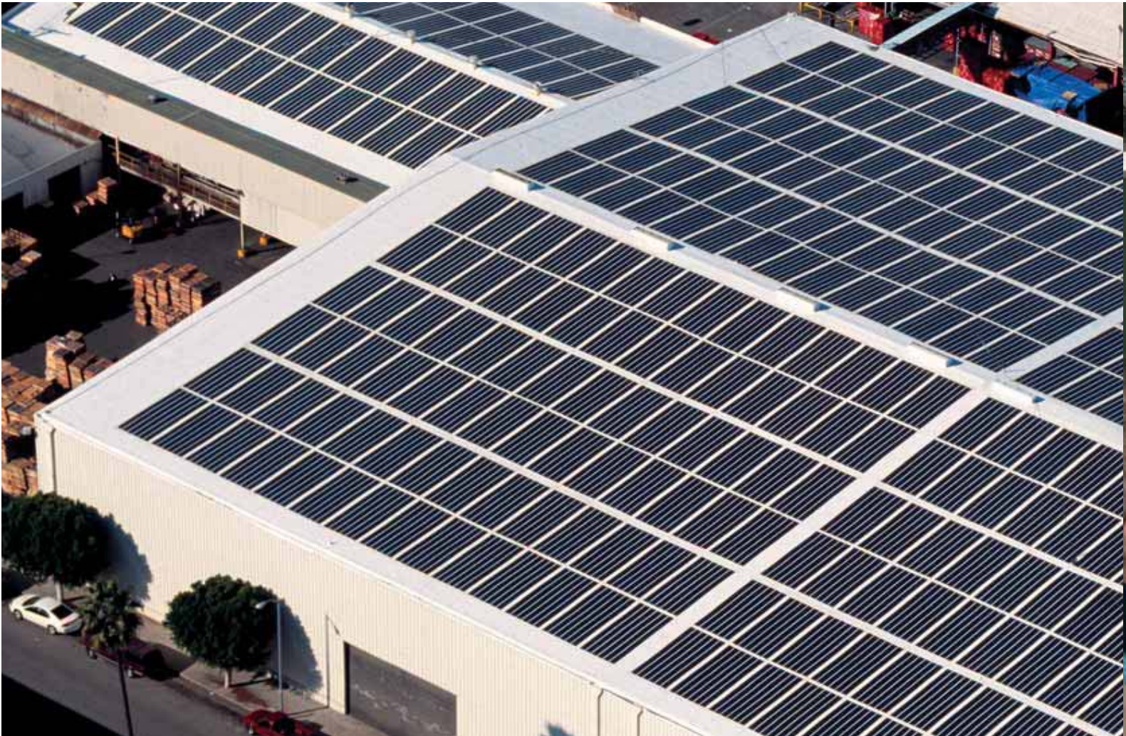
Copertura Coca Cola, Los Angeles
