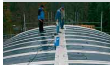
Copertura Wald-Solar-Heim, Eberswalde bei Berlin
