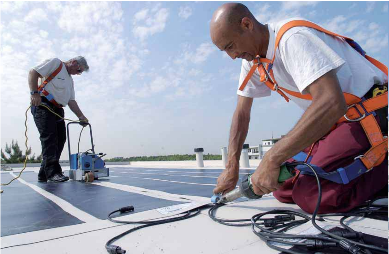
Saldatura degli elementi fotovoltaici
