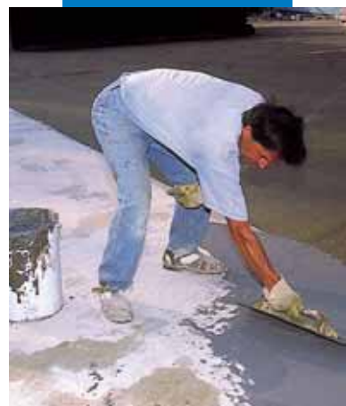
Impermeabilizzazione di una piscina con Mapelastick
