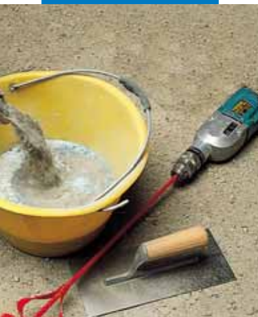
Impasto di Mapelastic con agitatore meccanico
