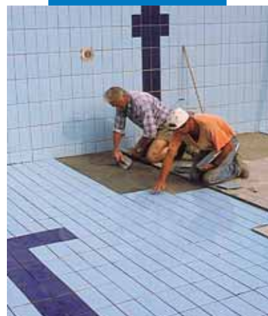
Posa di rivestimento ceramico su Mapelastick
